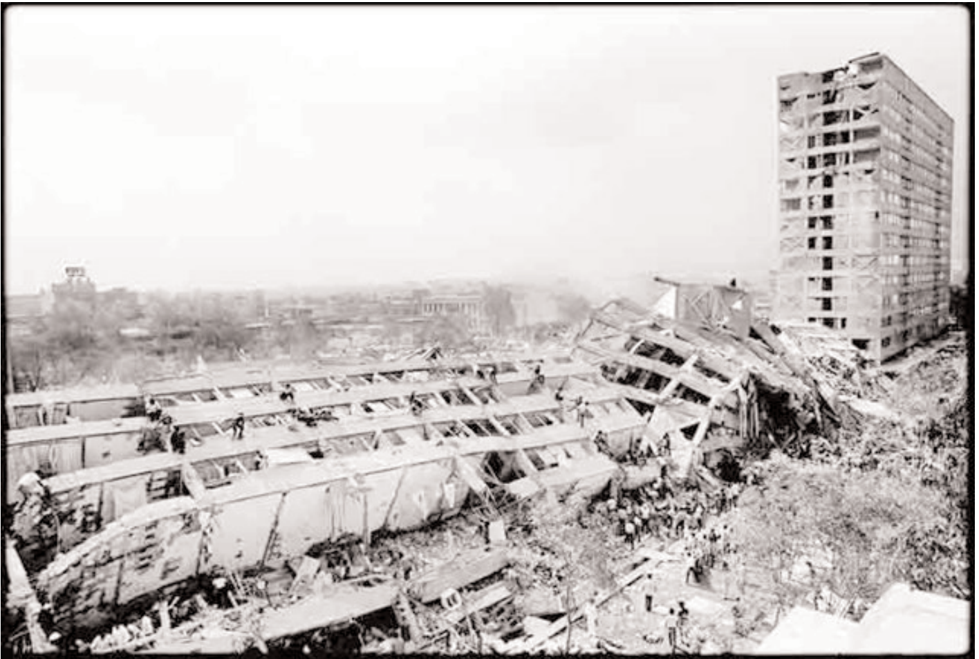
El escombros se fue encima después del terremoto 1985 de Ciudad de México. Foto: La Jornada
